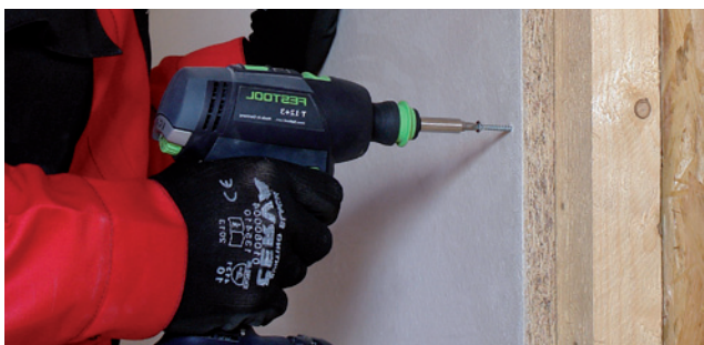
Zdjęcie nr 7 - Mocowanie za pomocą śrub
