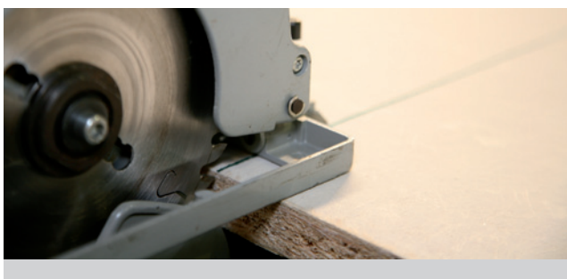
Zdjęcie nr 3 - Cięcie przy użyciu ręcznej piły obrotowej
