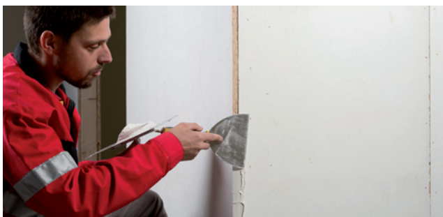
Zdjęcie nr 9 - Pokrywanie krawędzi
