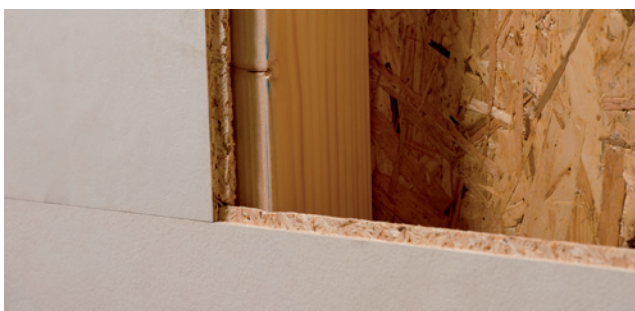
Zdjęcie nr 5 - Montaż na konstrukcji drewnianej
